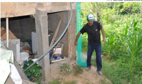
João Antônio mostra trinca em pilastra de sustentação de sua casa
