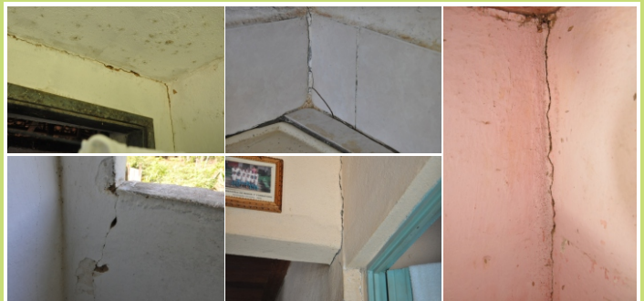
Trincas em casas da comunidade de Santana do Deserto
