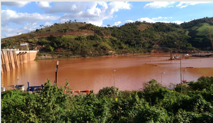
Área dos 400 metros próximos a barragem da UHE Candonga
